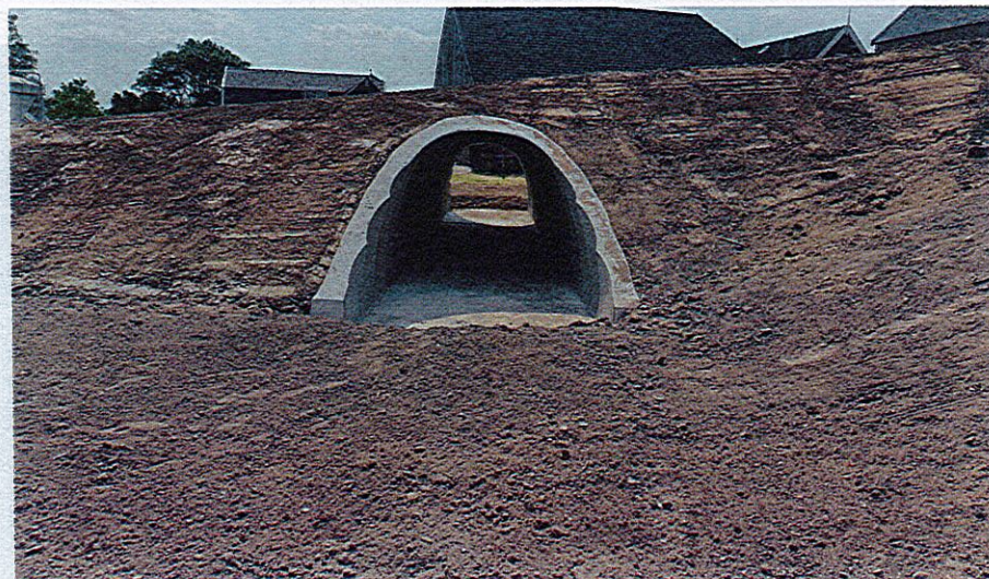
De eerste betonnen voetgangersbrug geïnspireerd op papier-maché bij Kinderdijk. Foto's BetonBallon
