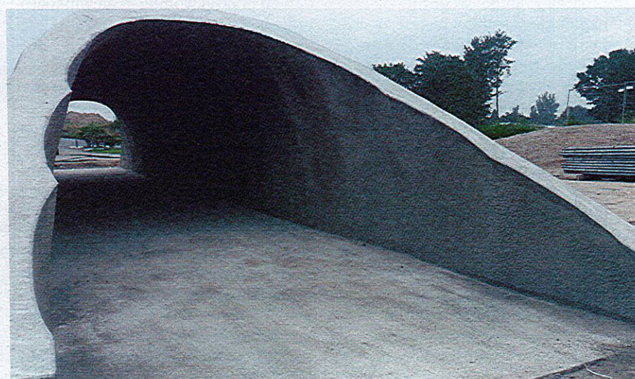
De tunnel na het verwijderen van de ballon.
