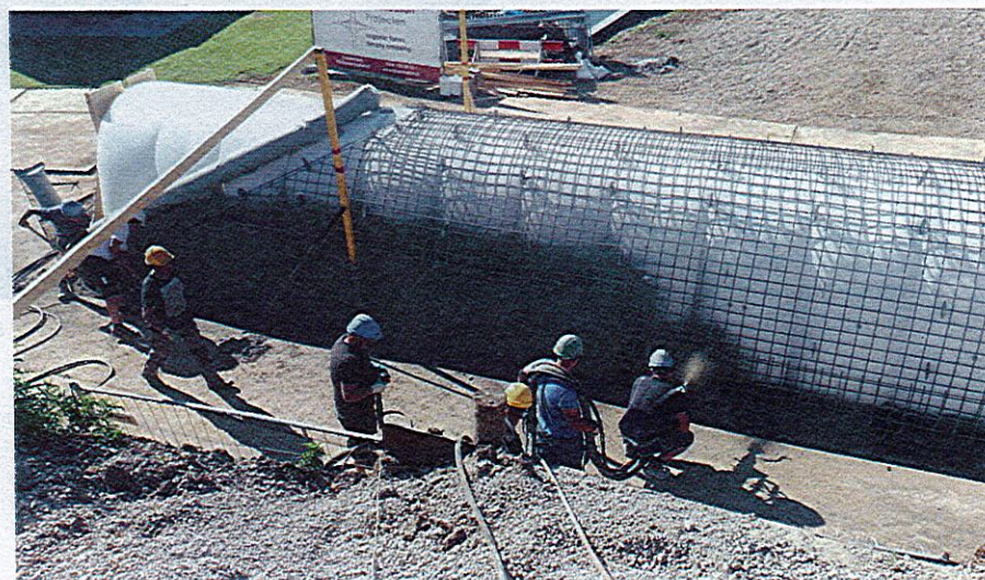
De BetonBallon-techniek wordt voor het eerst toegepast in de infra
